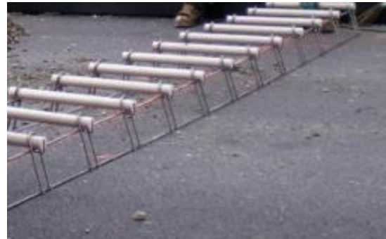
Рисунок 5.7 – Загальний вигляд та схема перерізу закладного елементу шва стискання, влаштованого за технологією розстановки закладних елементів (розміри показані в мм)
